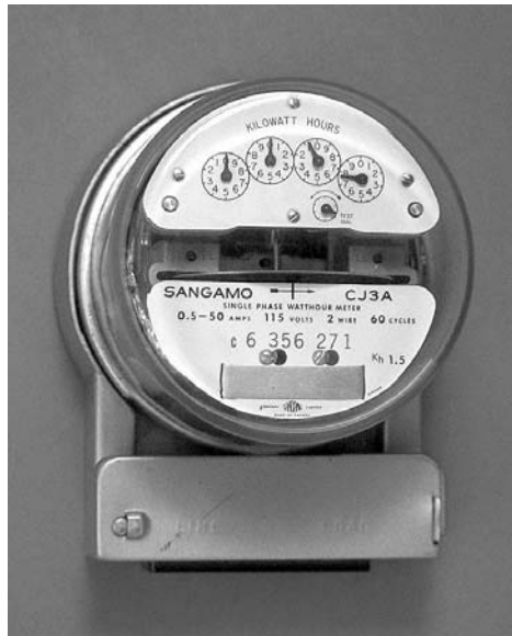
FIGURA 4-21 Medidor de watts-hora. Este usa un tren de engranes para manejar los diales. Los medidores más modernos tienen pantallas digitales.
